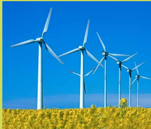
L'énergie éolienne est une des solutions du développement durable.
